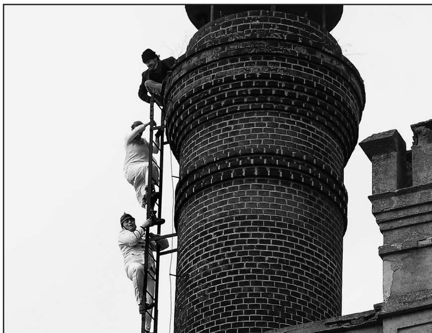
Když na komín, tak na komín – ve Vysokém Mýtě.
